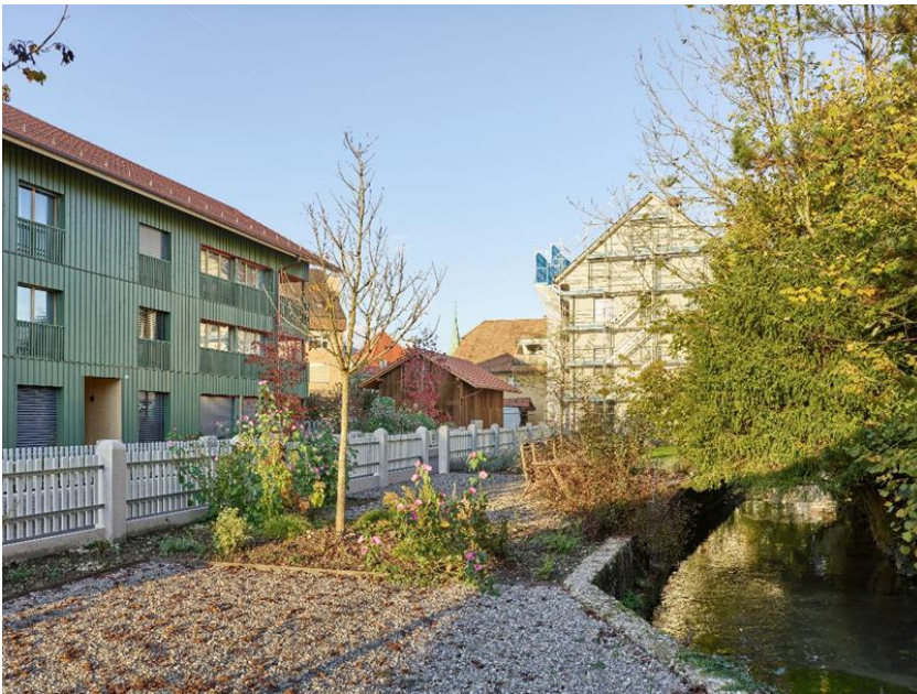
Im Garten, der dem Neubau gegenüberliegt, entstand ein Sitzplatz am Mülibach
